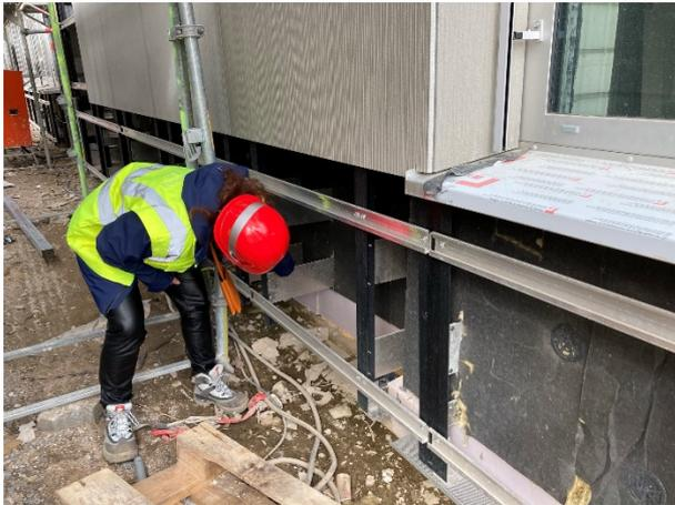
Konstruktion der vorgehängten Fassade
