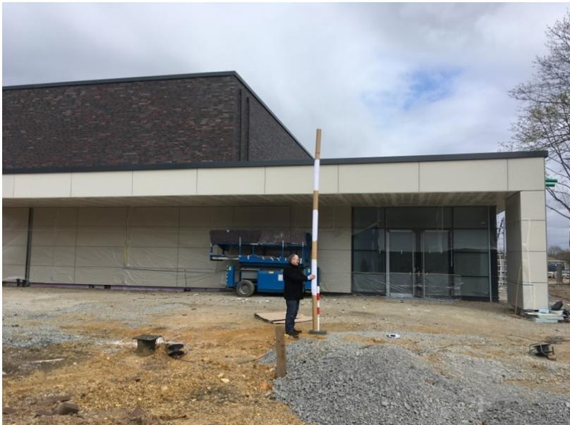
Überprüfung der Sichtbeziehungen anhand eines Musterteilelements 1:1
