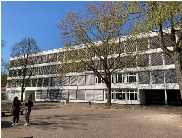
Abb.: Blick auf H-Gebäude
